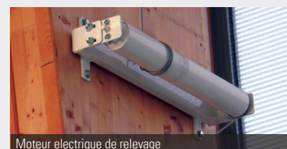
Moteur électrique de relevage
